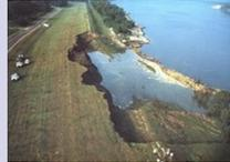
**niques**, ainsi que par l'**érosion** des matériaux qui le constituent, que ce soit en surface (affouillement, surverse...) ou directement dans le remblai (**fuites** dans l'ouvrage ou en fondation...). Pour prendre en compte ce risque, il est nécessaire de **quantifier** l'action des écoulements ainsi que la **résistance à l'érosion** des matériaux en présence.
