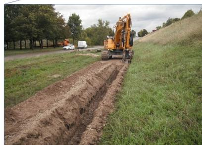
Fibre Optique enterrée dans une tranchée située par exemple en pied d'ouvrage pour mesurer la température, la déformation ou le bruit sismique
